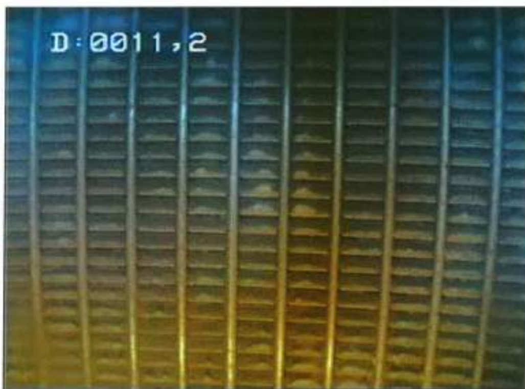
10- Tubage inox crépiné – quelques dépôts de fines
