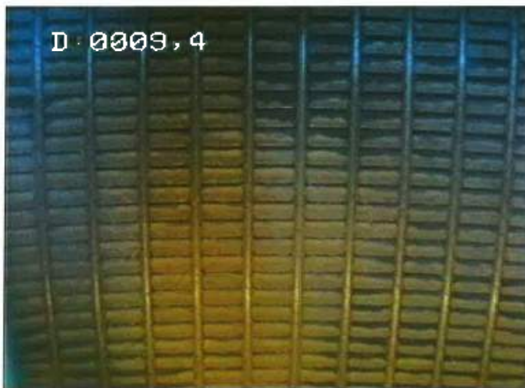
8- Tubage inox crépinée - présence de fines au droit des fentes
