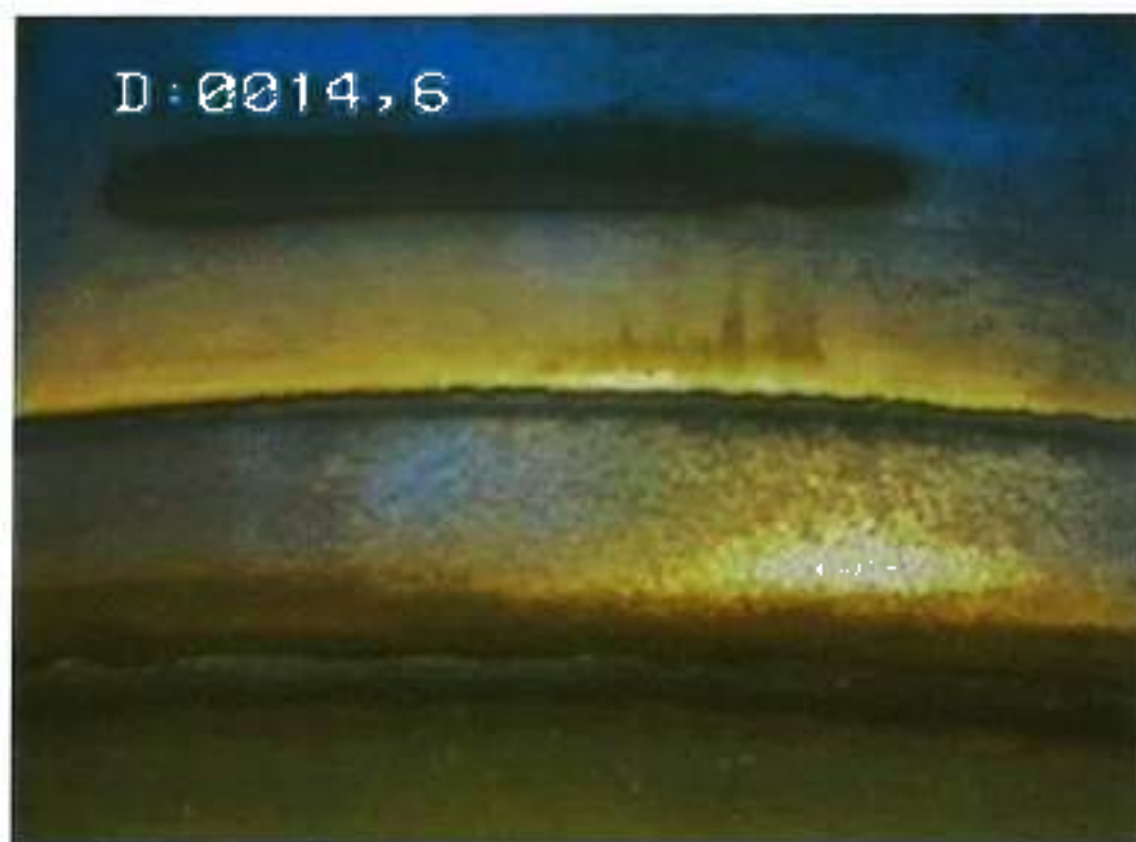
15- Tubage inox plein - sommet du cône de réduction
