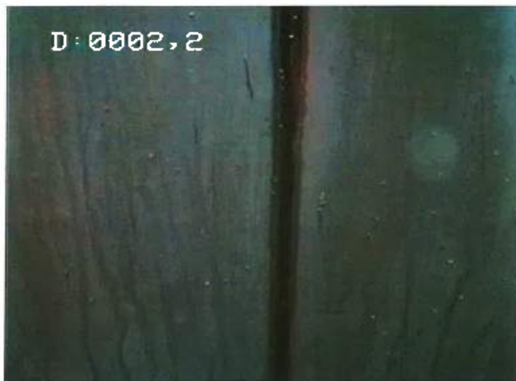
3- Tubage inox plein – soudure longitudinale, aspect propre
