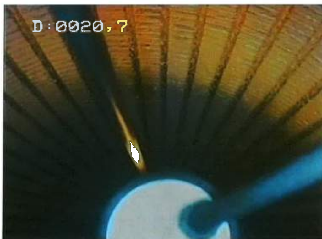
24- Tubage inox crépiné – fentes partiellement colmatées de fines
