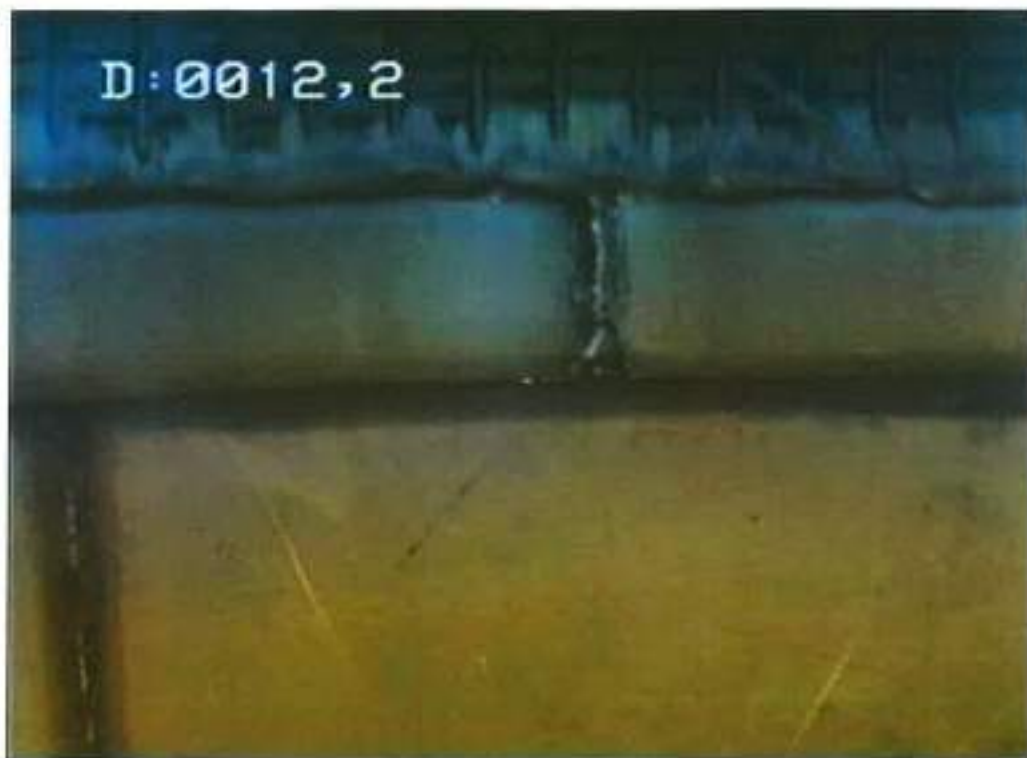
13- Tubage inox plein – jonction inter-tubes jointive
