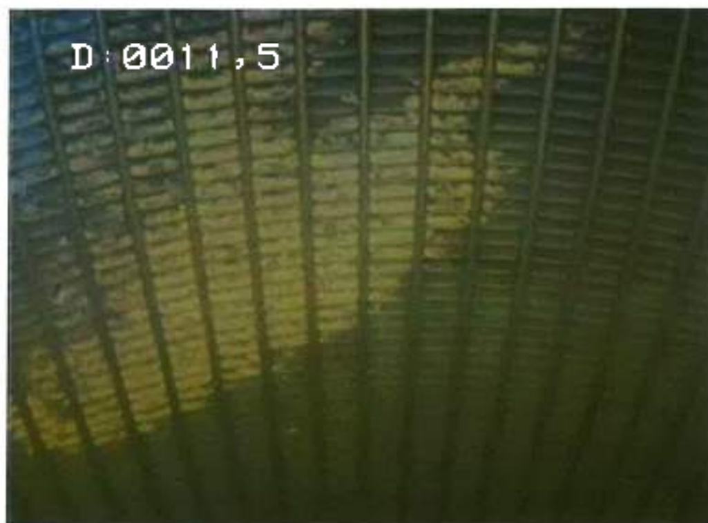
11- Tubage inox crépiné – quelques fentes plus colmatées
