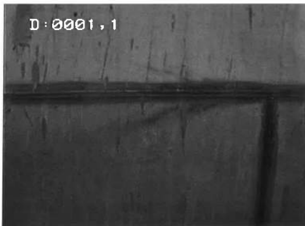
2- Tubage inox plein – soudure inter-tubes usine, aspect propre
