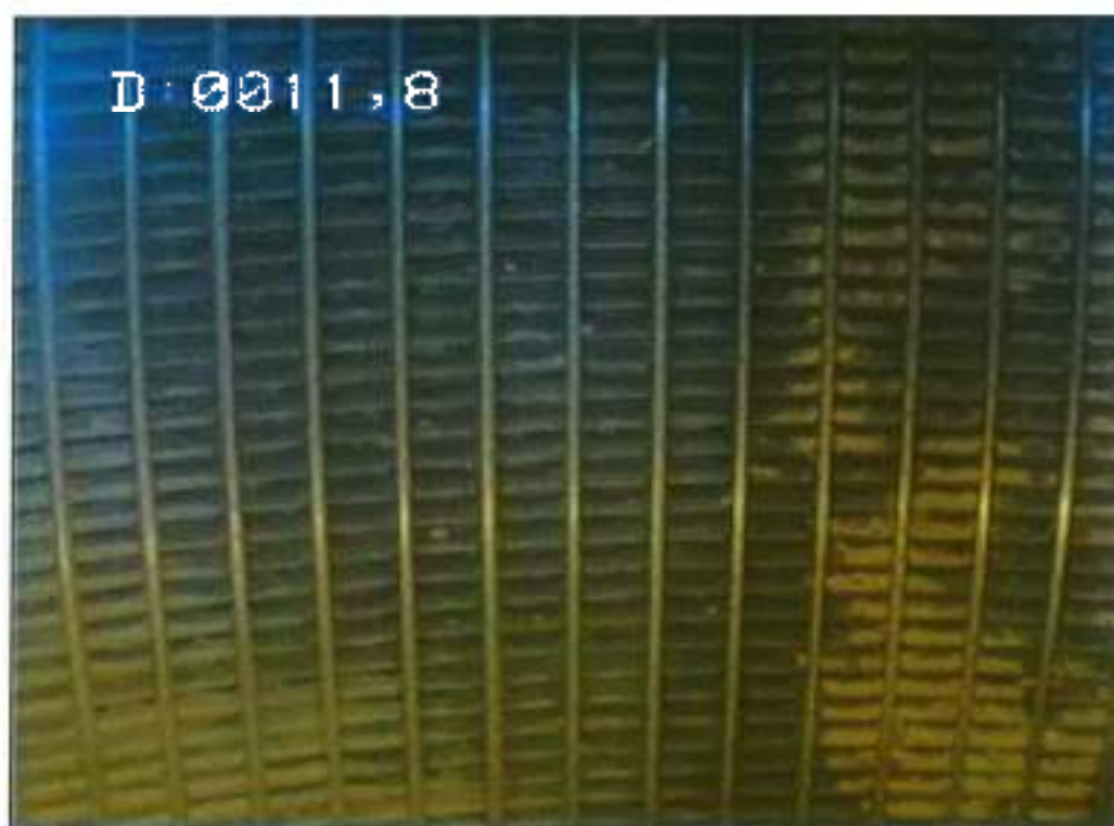
12- Tubage inox crépiné – fentes globalement ouvertes
